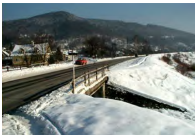
pôvodný stav mosta (1999)
